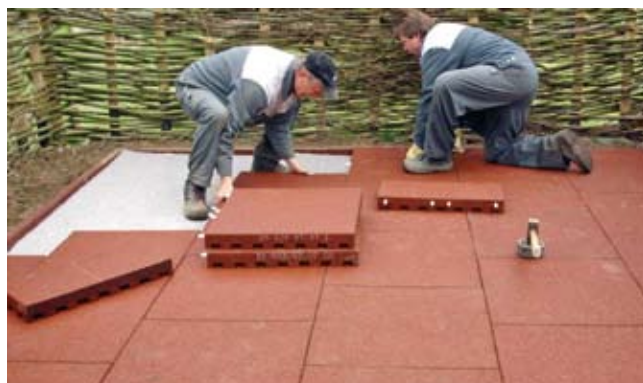
Aufbau: Fallschutzplatten Couche de surface: plaques de protection en cas de chute
